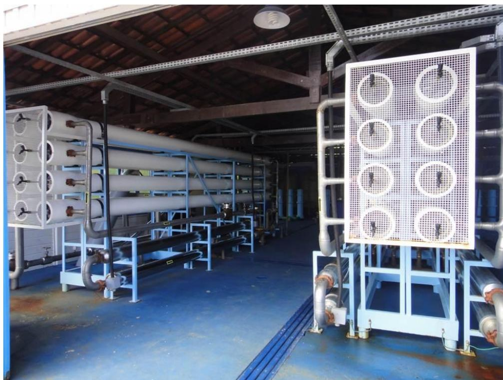
**Figura 10 – Sistema de dessalinização da água do mar instalado em Fernando de Noronha**
