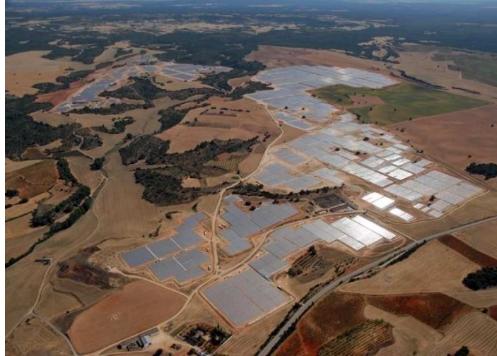
Figura 7- Parque Fotovoltaico Olmedilla de Alarcón, na Espanha. Fonte: NOBESOL - 2008
