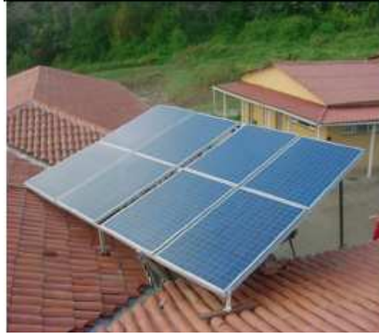
Figura 17 - Sistema de 2,4 kW p no Hospital São Lucas em Fernando de Noronha – PE Fonte: (BARBOSA, E.; LOPES; TIBA, 2004)
