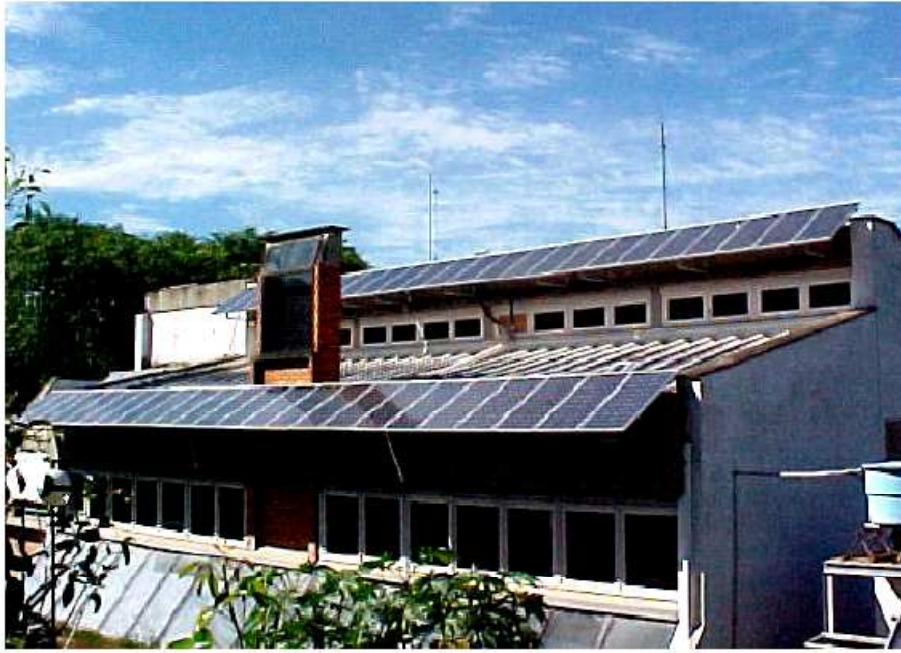
Figura 21- Sistema de 4,8 kW p no Campus da UFRGS Fonte: (DIAS, 2006)
