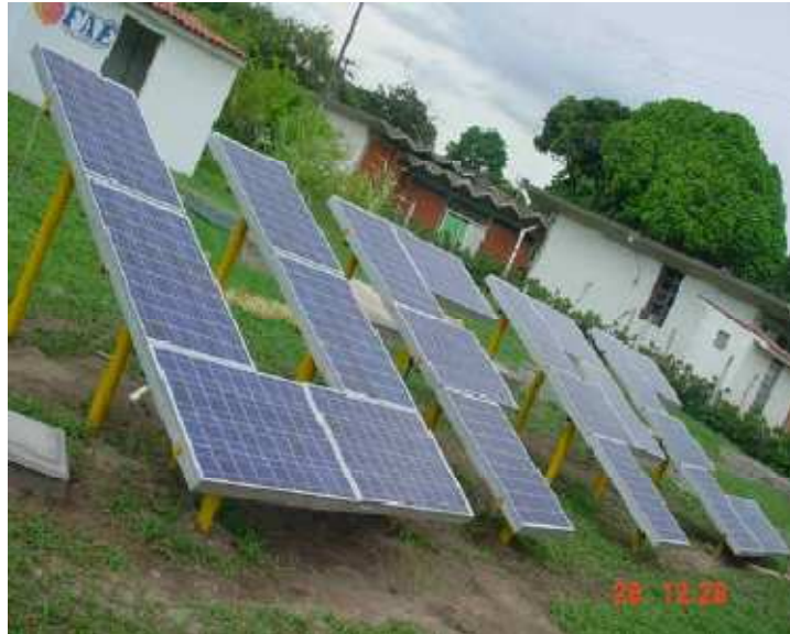
Figura 18 - Sistema de 1,28 kW p no Campus da UFPE Fonte: (BARBOSA, E. ; SILVA; MELO, 2007)
