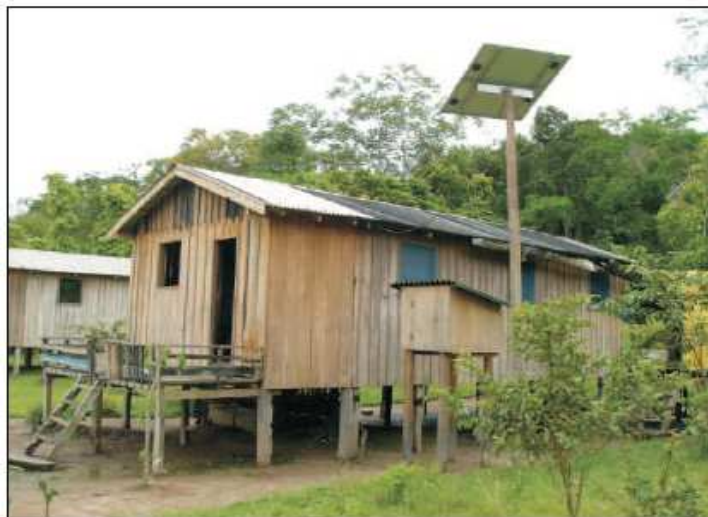
Figura 5 - Sistema Fotovoltaico Domiciliário em São Francisco do Aiucá – AM. Fonte: (MOCELIN, 2007)
