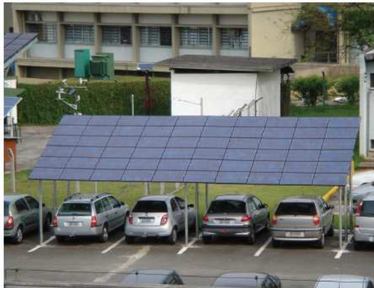
Figura 26 - Sistema de 3,0 kW p no estacionamento do IEE-USP Fonte: Roberto Zilles, 2004
