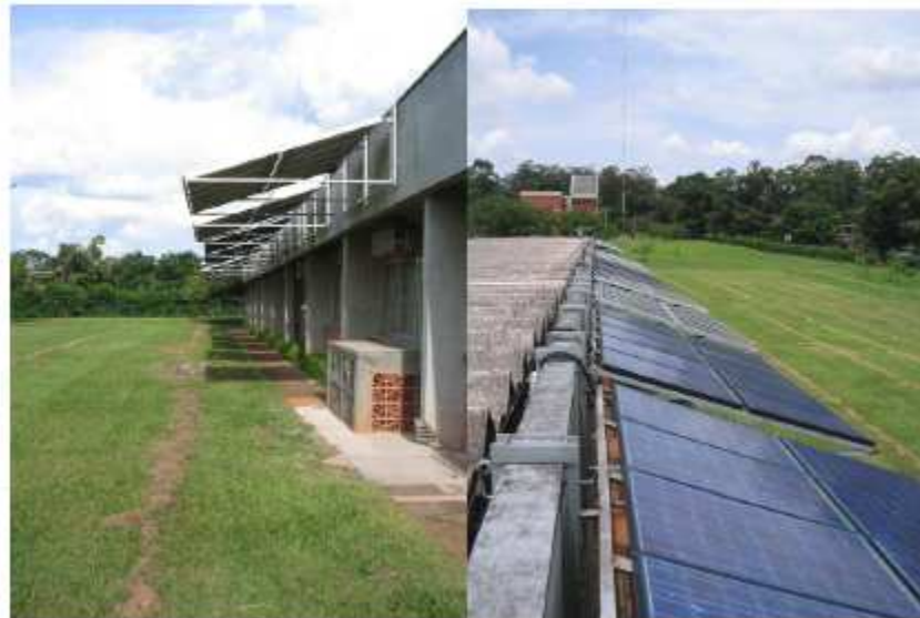
Figura 24 - Sistema de 12,3 kW p instalado no prédio da Administração do IEE-USP Fonte: (MACEDO; ZILLES, 2007)
