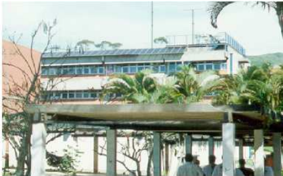
Figura 15 - Sistema de 2,0 kW p no prédio da Engenharia Mecânica da UFSC Fonte: (RÜTHER, R. et al., 2006)
