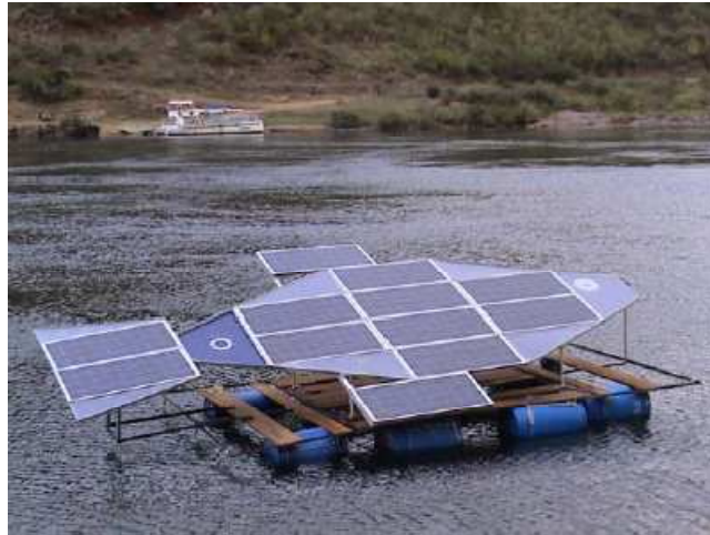
Figura 19 - Sistema de 1,5 kW p no Restaurante Lampião Fonte: (BARBOSA, E. et al., 2008)
