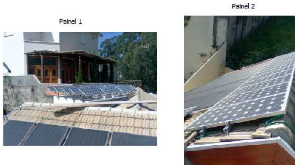
Figura 33 - Sistema de 2,9 kW p em residência particular em São Paulo-SP Foto: Ebea Engenharia
