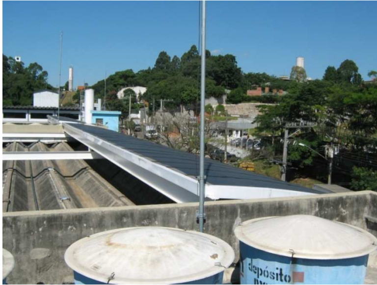
Figura 30 - Sistema de 14,7 kW p da Fundação Estrela – Grupo Zeppini Foto: Ricardo Benedito, 2009.
