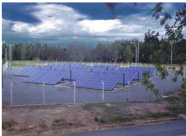
Figura 23 - Geradores da usina fotovoltaica de 31,70 kW p da UFJF Fonte: (VINAGRE, 2005)
