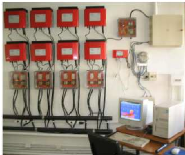
Figura 25 - Sala de monitoramento do sistema de 12,3 kW p do IEE-USP Fonte: (MACEDO; ZILLES, 2007)
