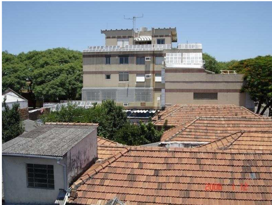
Figura 29 - Sistema de 3,3 kW p da Intercâmbio Eletro Mecânico – RS
