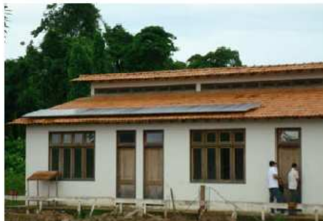
Figura 27 - Sistema de 1,58 kW p do GEDAE - UFPA Fonte: MACEDO et al. (2008)
