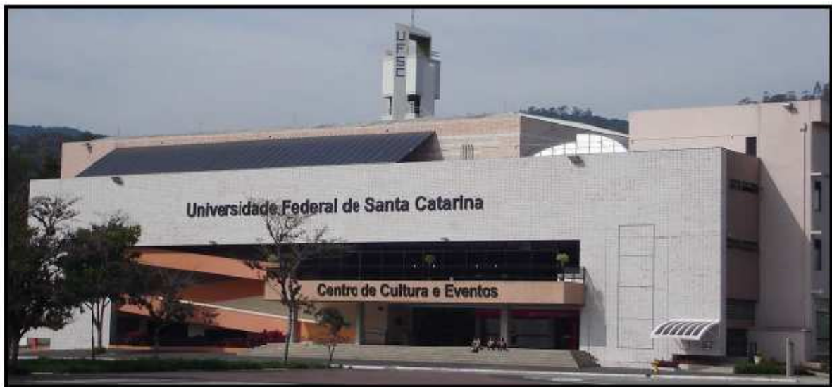
Figura 16 - Sistema de 10,2 kW p na cobertura do Centro de Cultura e Eventos da UFSC Fonte: (VIANA et al., 2007)
