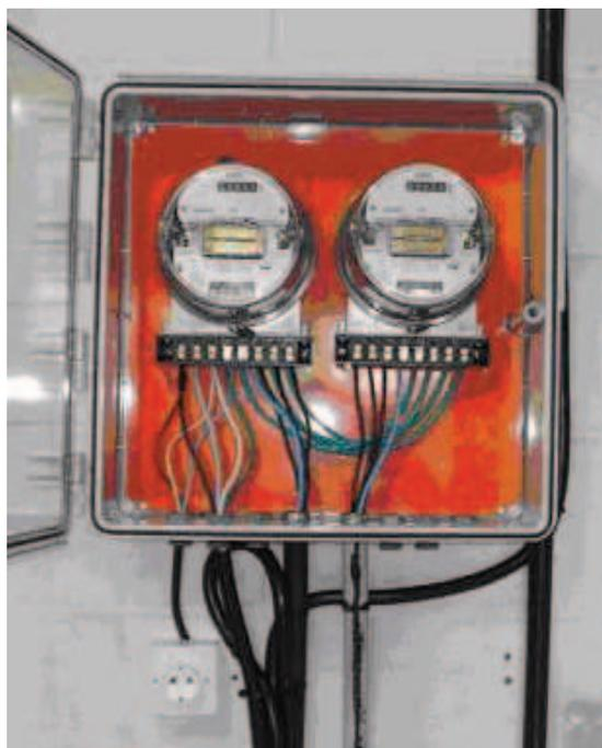
**Figura 18.** Detalhe da medição.
