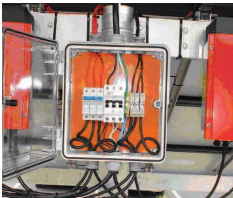
**Figura 17.** Detalhe da proteção em cc e ca.
