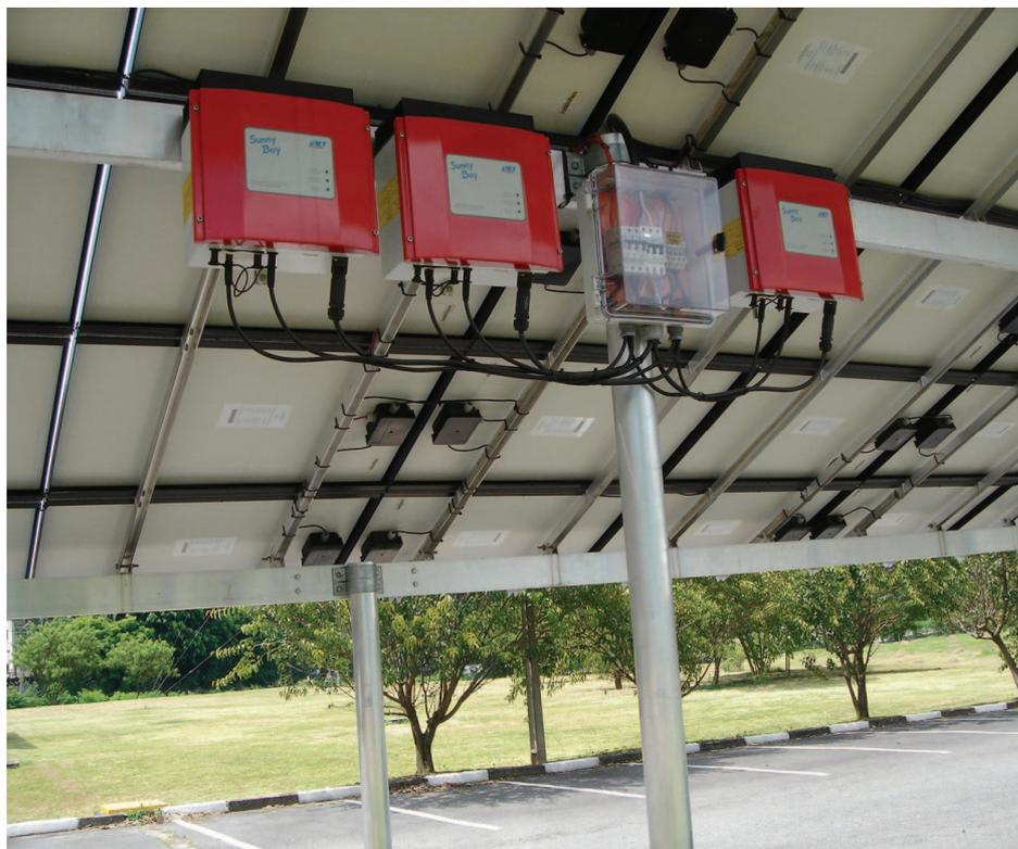
**Figura 14.** Inversores instalados na estrutura de suporte dos módulos, exposta diretamente às condições meteorológicas.
