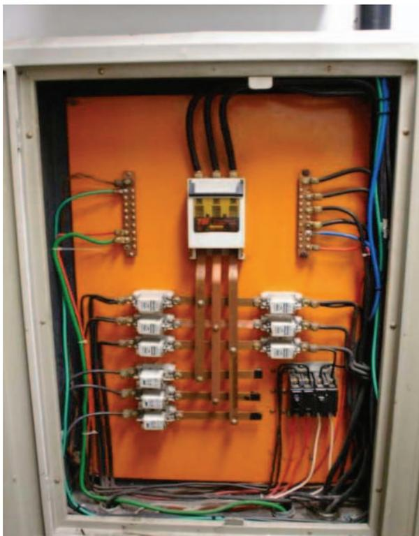
**Figura 9.** Quadro de distribuição com a interconexão do sistema fotovoltaico.
