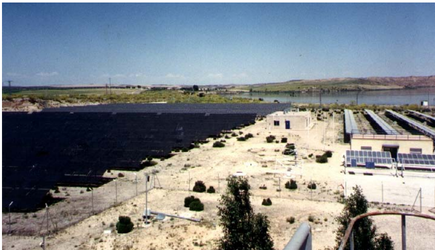
Figura 18. Vista panorâmica de parte da central de Toledo – 1MW p .
