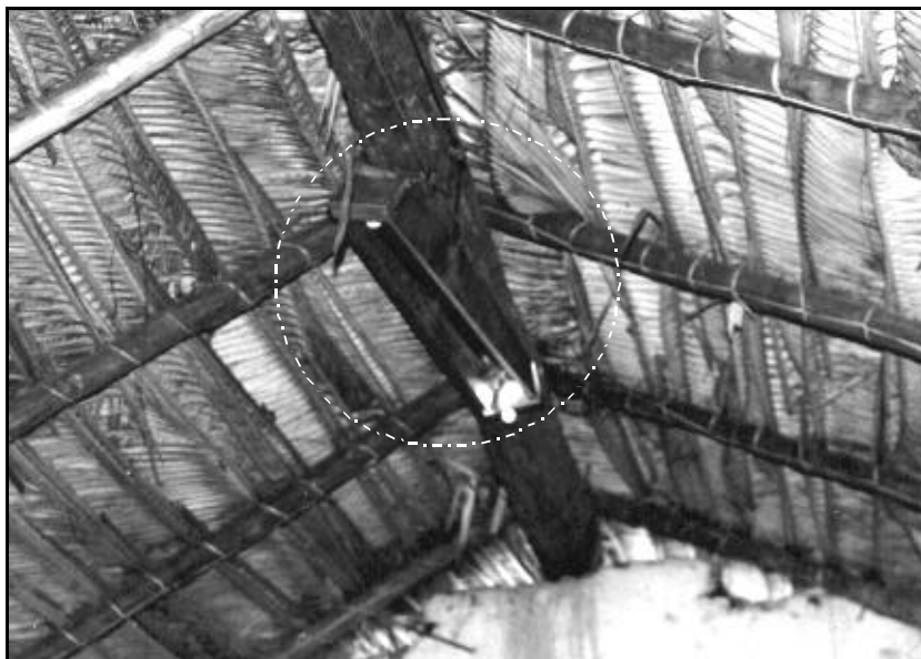
Figura 2.20: Luminária desativada devido a defeito no reator (ela está enegrecida devido à fumaça do fogão a lenha).
