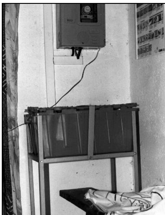
Figura 2.17: Caixa da bateria, quadro de entrada e cartaz de orientações.
