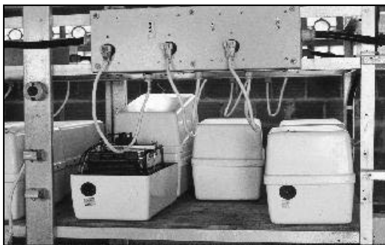
Figura 2.24: Kit domiciliar de bateria: um controlador de descarga e uma bateria "livre de manutenção" de 95Ah.
