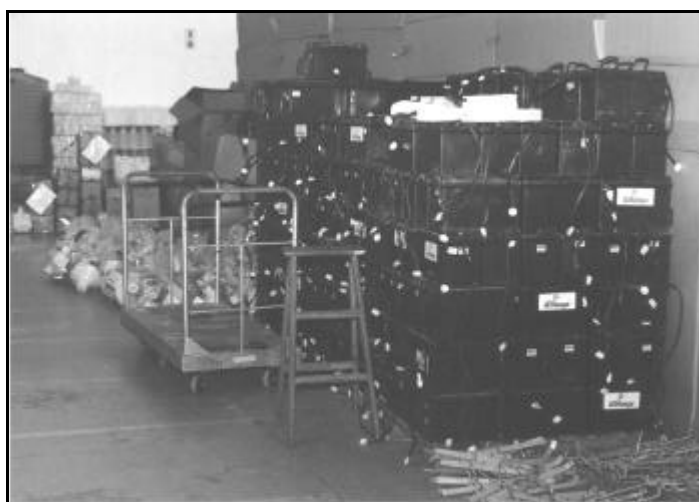
Figura 2.11: Depósito de baterias na sede da JV.
