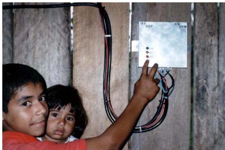
Figura 6.15 – Detalhe do controlador de carga.
