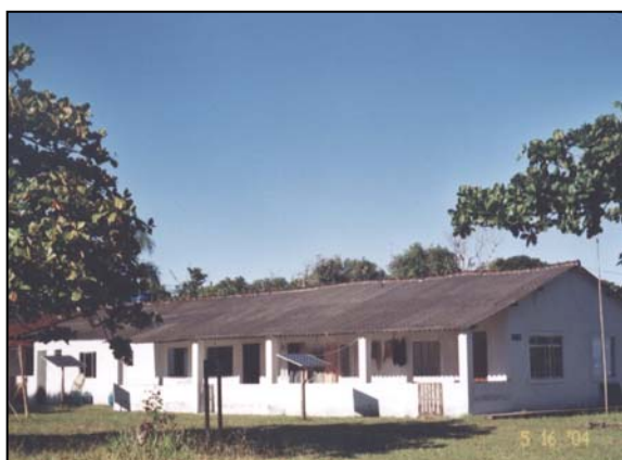
Figura 4.6. Instalação fotovoltaica da comunidade de Marujá. [Foto: F. Morante, 16/05/2004]
