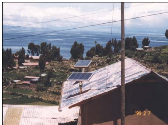
Figura 4.27. Moradia típica de Taquile e o gerador fotovoltaico utilizado.
