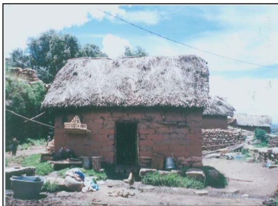
Figura 3.8. Moradia sem eletricidade, embora a rede elétrica passe por cima da casa. Comunidade de Suaquello – Huancané - Puno – Peru. [Foto: F. Morante, 13/08/2000]
