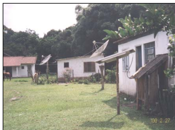
Figura 4.7. Instalações fotovoltaicas da comunidade de Sítio Artur. [Foto: F. Morante, 27/02/2000]
