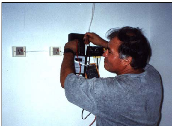
Figura 5.3. Um dos momentos da instalação de um contador de Ah no Vale do Ribeira. [FOTO: R. Zilles, 21/03/1999]
