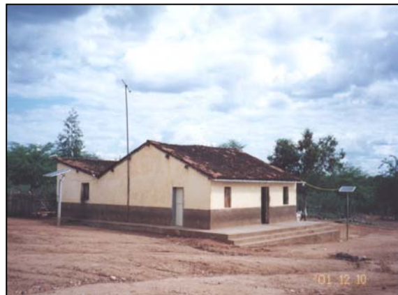
Figura 4.10. Moradia de Pedra Branca e o gerador FV utilizado. [Foto: F. Morante, 10/12/2001]
