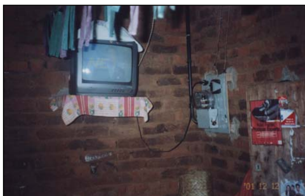
Figura A2.6. A televisão ao lado do medidor de kWh instalado no interior da moradia.
