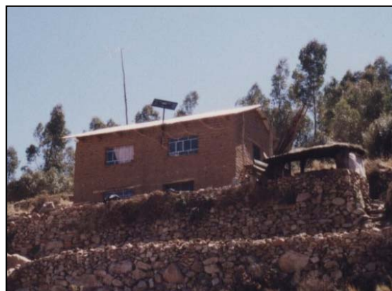
Figura 4.31. Moradia de Huancho Lima e o gerador fotovoltaico utilizado. [Foto: F. Morante, 12/08/2000]
