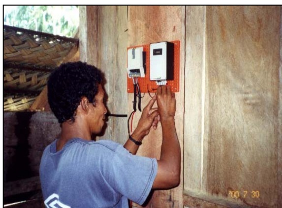
Figura 5.13. Montagem de um contador de Ah por um morador de Vera Cruz. [Foto: F. Morante, 30/07/2000]
