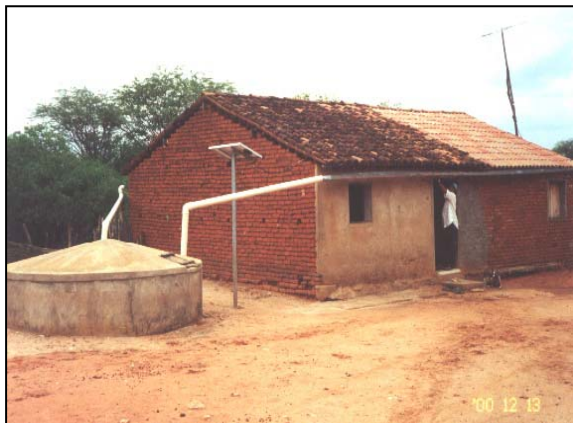
Figura 4.9. Moradia e gerador FV de Pedra Branca. [Foto: F. Morante, 13/12/2000]
