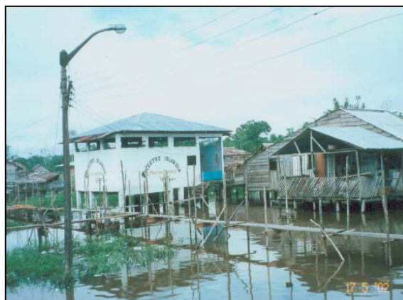
Figura 3.7. Rede elétrica utilizando um gerador diesel. Comunidade Islândia – Rio Javari – Loreto – Peru [Foto: F. Morante, 17/05/2002]
