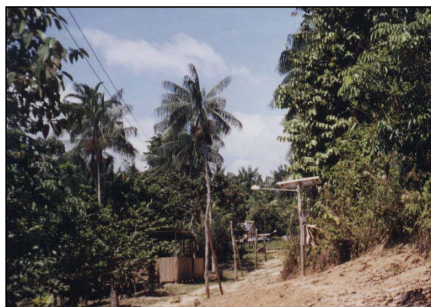
Figura 4.22. Aspecto do caminho principal da comunidade e poste de iluminação pública. [Foto: F. Morante, 07/12/2003]
