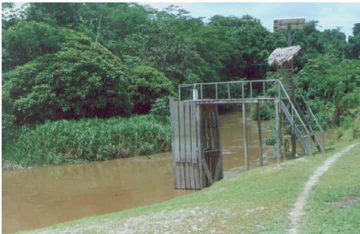
Figura 4.4 – Sistema de bombeamento na várzea, em terreno com baixa permeabilidade, em época de estiagem. (Foto: M.C. Fedrizzi, 2002)
