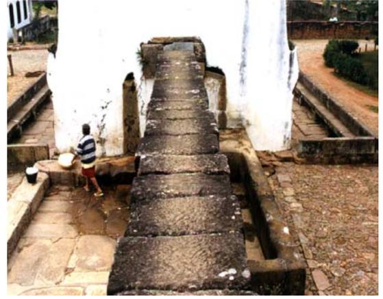
Figura 1.4 – Fundos da fonte ao lado, com divisões para coleta de água, lavagem de roupa e dessedentação de animais. (Foto: M.C. Fedrizzi, 2000)
