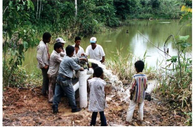
Figura II.6 Perfuração de um poço. (foto: M.C. Fedrizzi, 1999)
