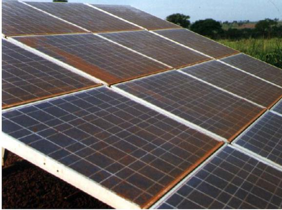
Figura 3.20 – Sombreamento de módulos fotovoltaicos por poeira, SP.
