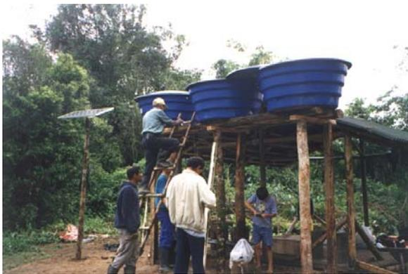
Figura I.14 Instalação dos reservatórios. (Foto: M.C. Fedrizzi, 1998)
