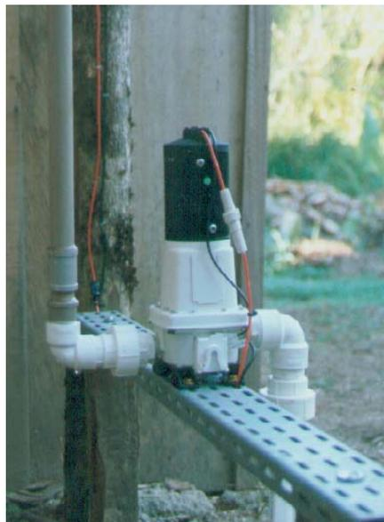
Figura 4.1 – Sistema de bombeamento fotovoltaico de superfície.
