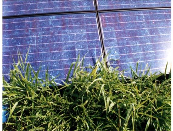
Figura 3.21 – Sombreamento de módulos fotovoltaicos por vegetação rasteira, SP.
