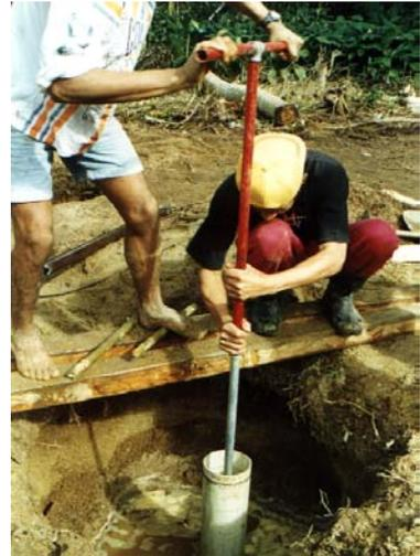
Figura I.13 Abertura dos poços. (Foto: M.C. Fedrizzi, 1998)
