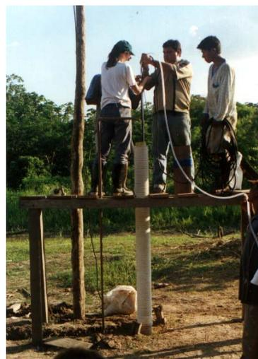
Figura II.10 Instalação de um grupo motobomba. (foto: M.C. Fedrizzi, 1999)
