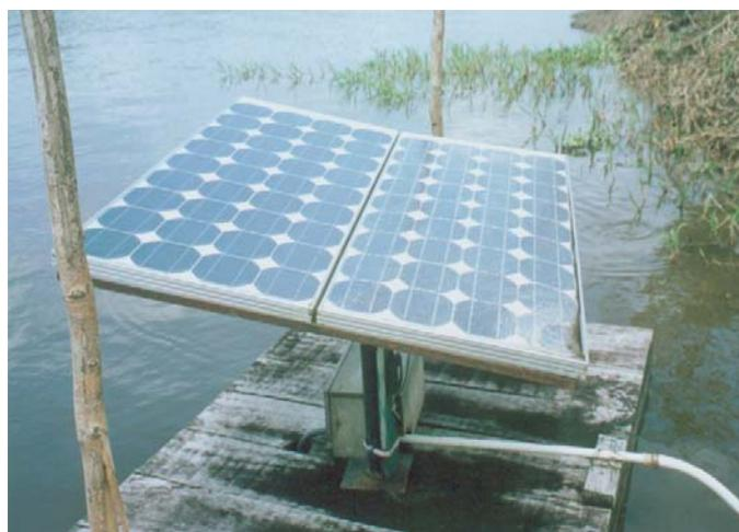
Figura 4.3 – Sistema de bombeamento fotovoltaico de superfície instalado em flutuante. (Foto: M.C. Fedrizzi, 2002)
