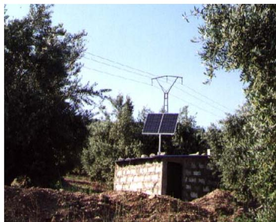
Figuras 2.11 e 2.12 – Sistemas de bombeamento fotovoltaico utilizados para irrigação de oliveirais, instalados nas proximidades de uma rede de transmissão de energia elétrica em Jaén, Espanha.
