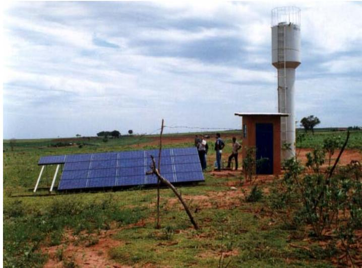
Figura 4.2 – Sistema de bombeamento fotovoltaico em poço tubular, terra firme.
