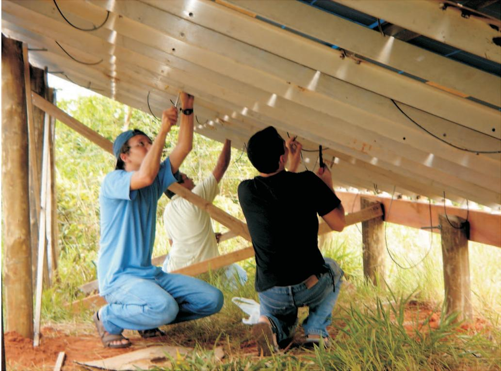
Figura 3.16: Montagem do gerador fotovoltaico.
