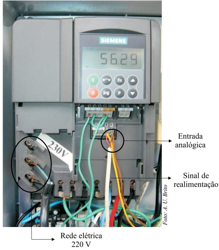
Figura 3.5: Vista do conversor de frequência utilizado - Micromaster 420 de 2 CV.
