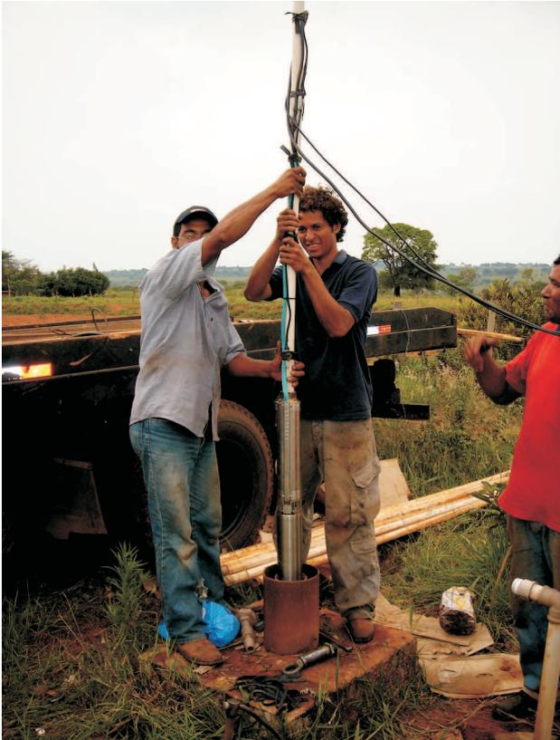
Figura 3.17: Instalação da motobomba.
