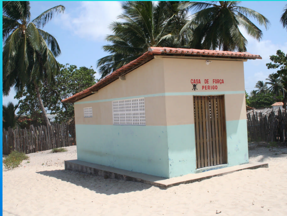
Abrigo do Grupo Motor-Gerador
