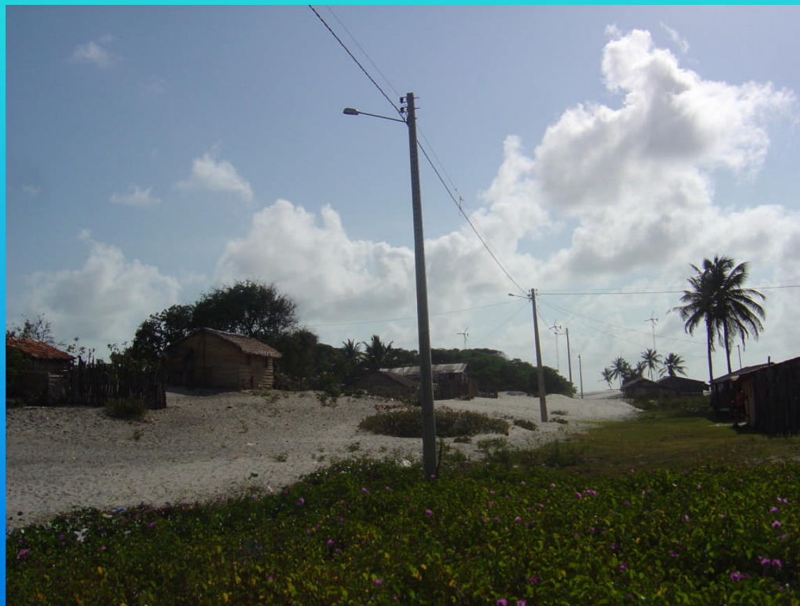
Rede de Distribuição
