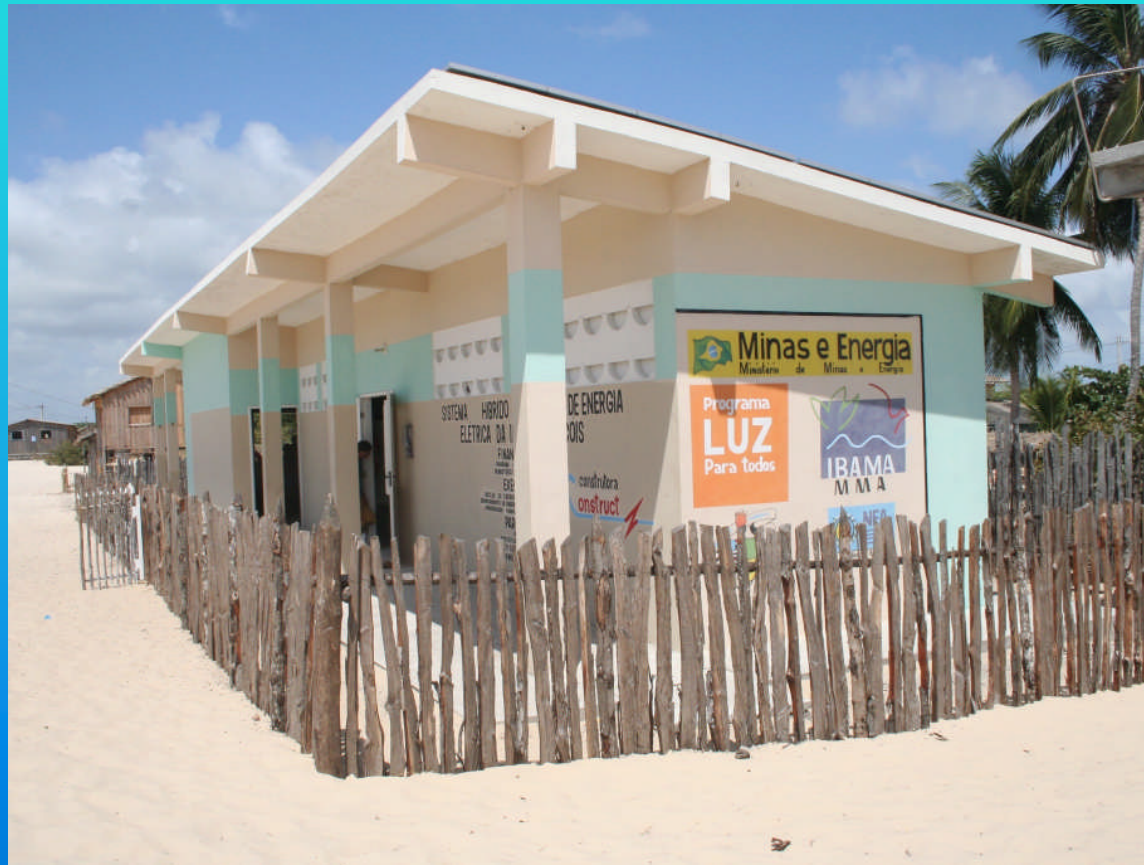
Casa de Força e Controle
