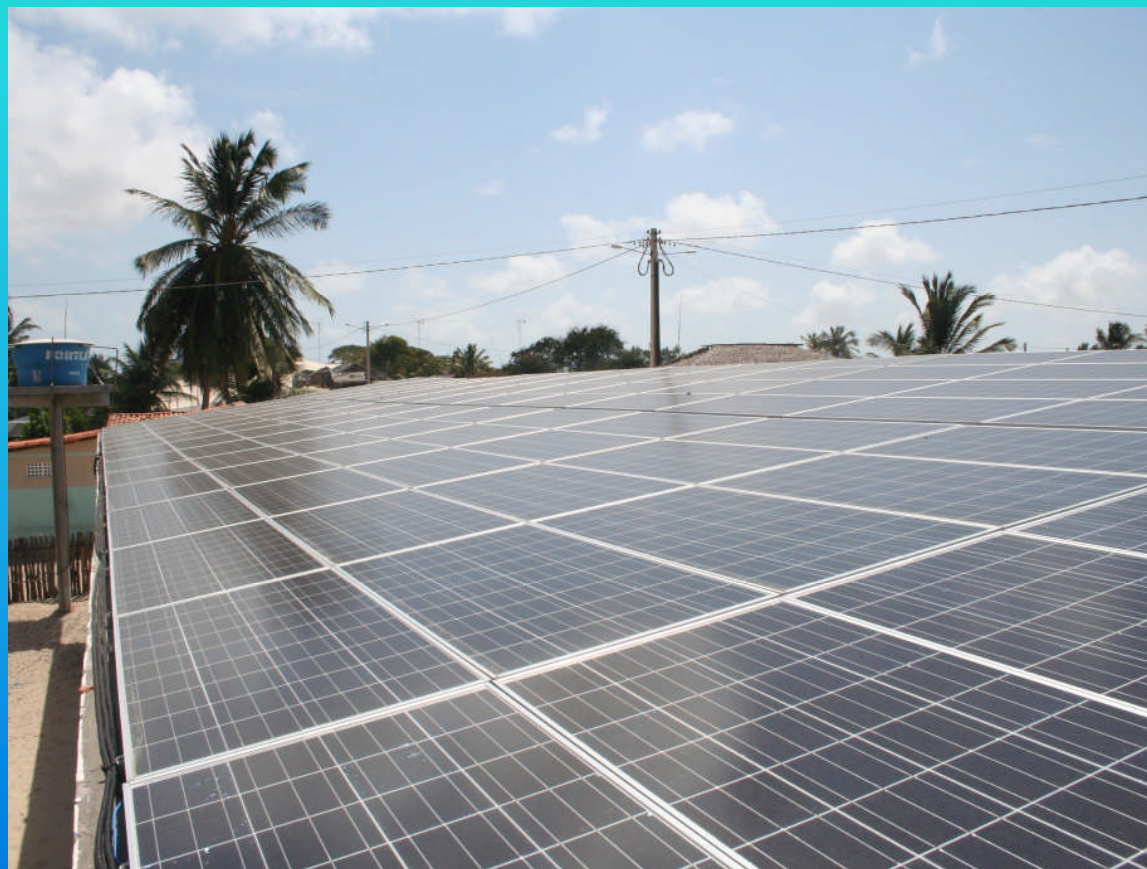
Painel Solar Fotovoltaico
