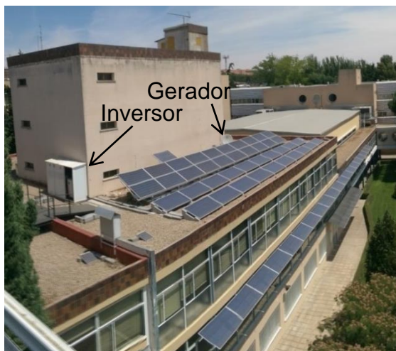
Figura 3.20 – Vista aérea das instalações do IES-UPM: a série FV objeto de estudo é composta pelas duas fileiras superiores.
