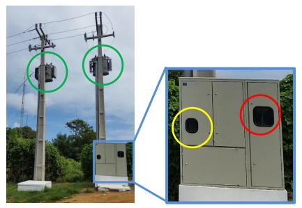
Figura B.9 – Ponto de conexão à rede da usina, contendo os transformadores BT/MT (círculos verdes), o medidor de faturamento (círculo amarelo) e um DSV (círculo vermelho).
