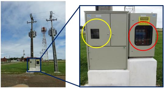
Figura B.5 – Ponto de conexão à rede da usina, contendo o medidor de faturamento (círculo amarelo) e um DSV (círculo vermelho).
