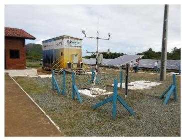
Figura B.4 – Estação solarimétrica e eletrocentro da Usina Fotovoltaica Noronha I.
