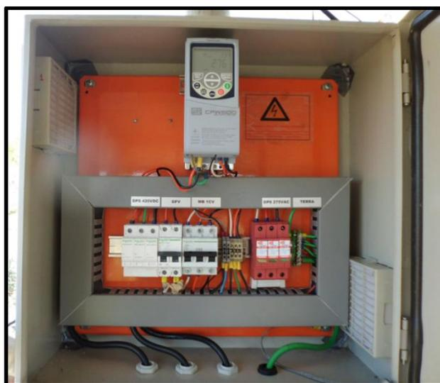
Figura 5.1: Quadro elétrico com o CFW500
