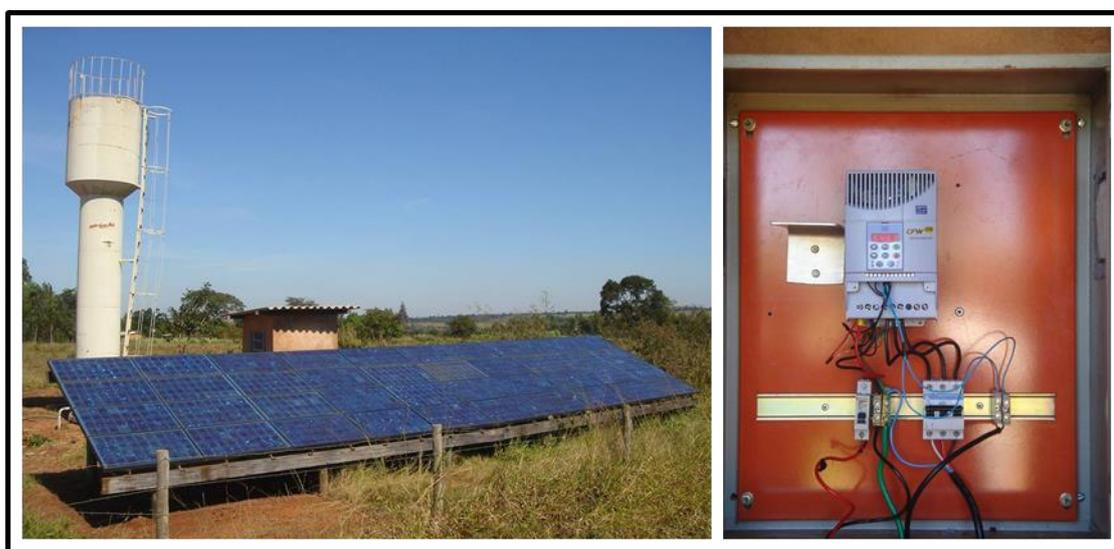
**Figura 3.11: SFB-CF instalado no Pontal de Paranapanema e quadro com CF**
