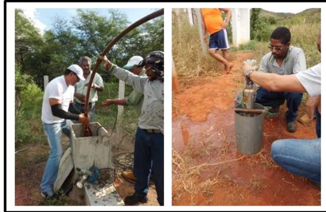
**Figura 5.19: Remoção da motobomba e teste em superfície**
