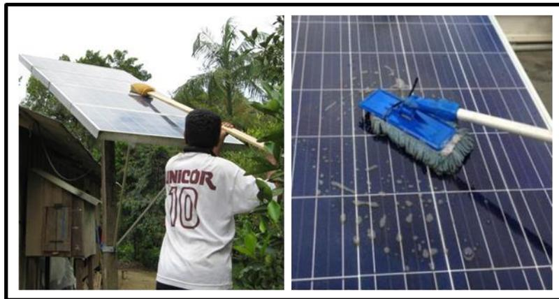
**Figura 5.8: Tarefa de manutenção preventiva - limpeza dos módulos fotovoltaicos**
