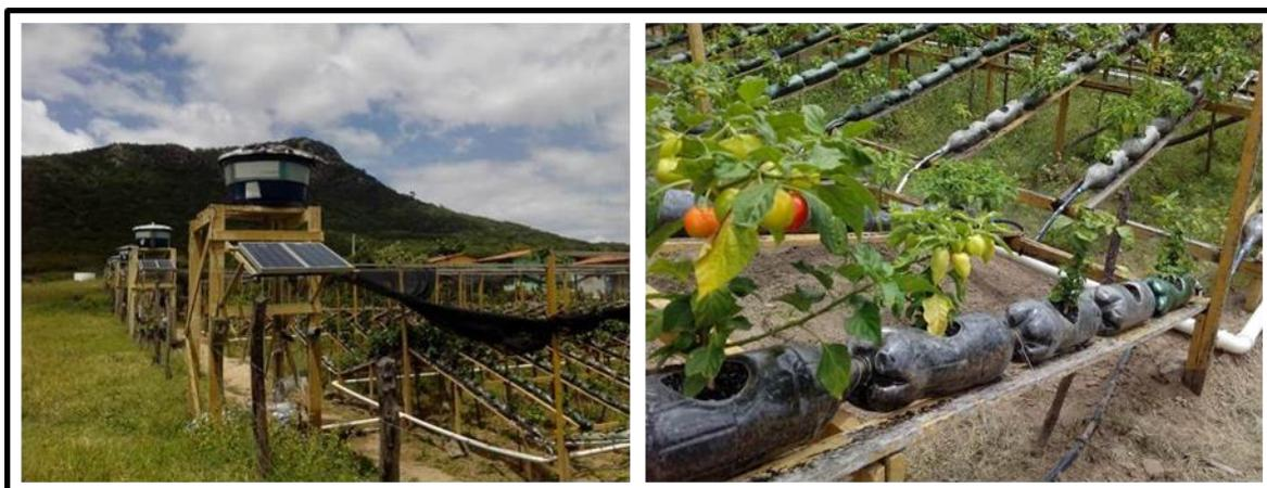
**Figura 2.11: Sistema fotovoltaico para a produção hidropônica de pimenta em São José da Tapera**
