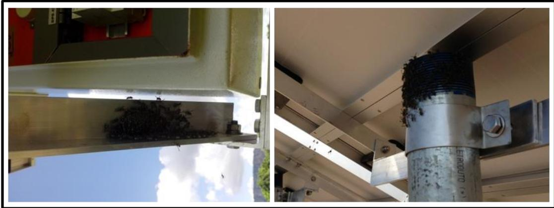
**Figura 5.9: Ocorrências detectáveis pelos usuários dos SFB-CF - Presença de insetos na estrutura do gerador fotovoltaico**
