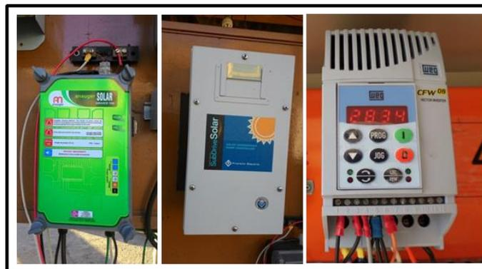
**Figura 4.17: Exemplo de sistemas de condicionamento de potência de sistemas de bombeamento e conversor de frequência**
