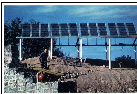
**Figura 2.3: Sistema fotovoltaico de bombeamento de 600 Wp instalado em 1981**
