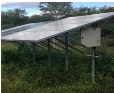
Figura 5 – Gerador fotovoltaico e dispositivo de condicionamento de potência.
