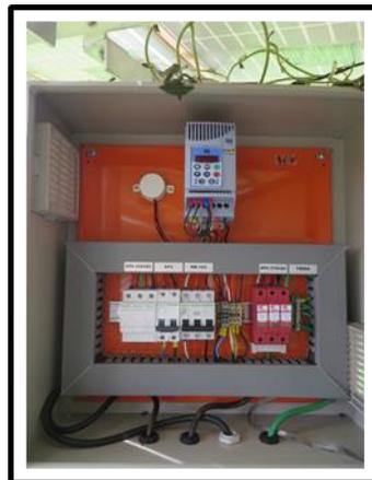
**Figura 5.11: Ocorrências detectáveis pelos usuários dos SFB-CF - vegetação crescida próximo ao quadro elétrico do SFB-CF**
