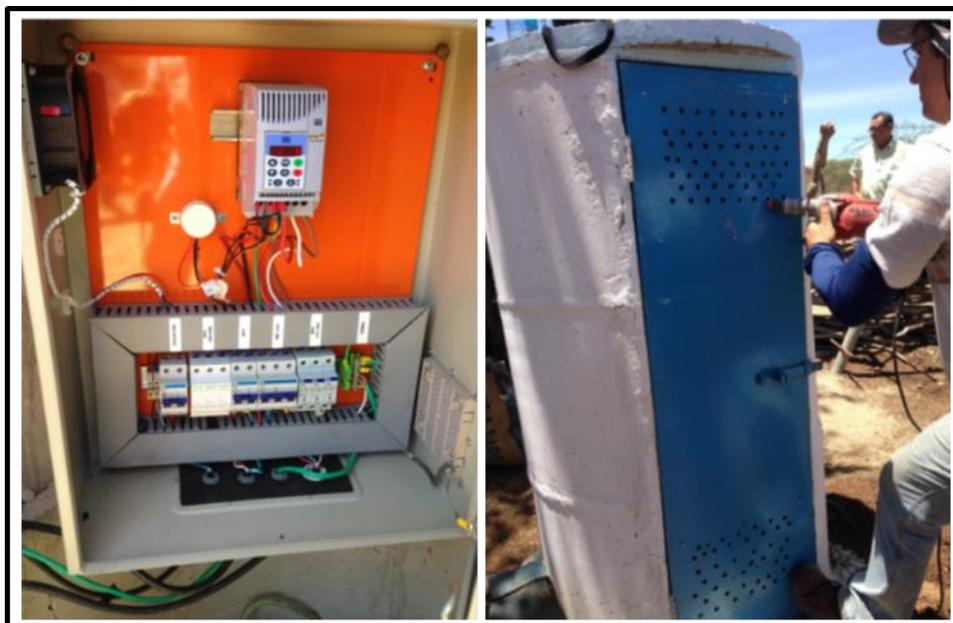
**Figura 3.16: Quadro elétrico e abrigo do quadro**
