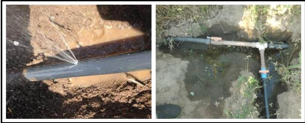
**Figura 5.14: Ocorrências detectáveis pelos usuários dos SFB-CF - vazamentos na rede hidráulica**
