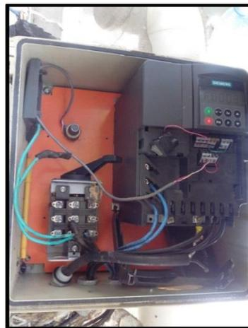
**Figura 3.7: Quadro elétrico com CF configurado segundo Melo (2004)**
