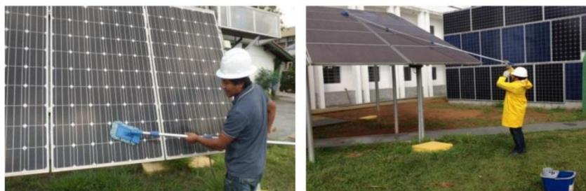
*Figura 3 – Limpeza dos módulos fotovoltaicos.*
