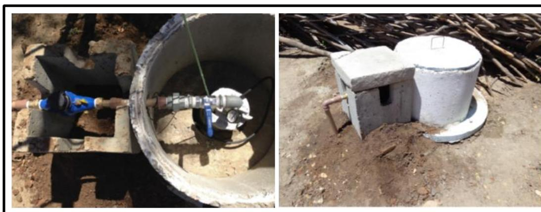
**Figura 3.17: Vista superior e frontal da boca do poço**
