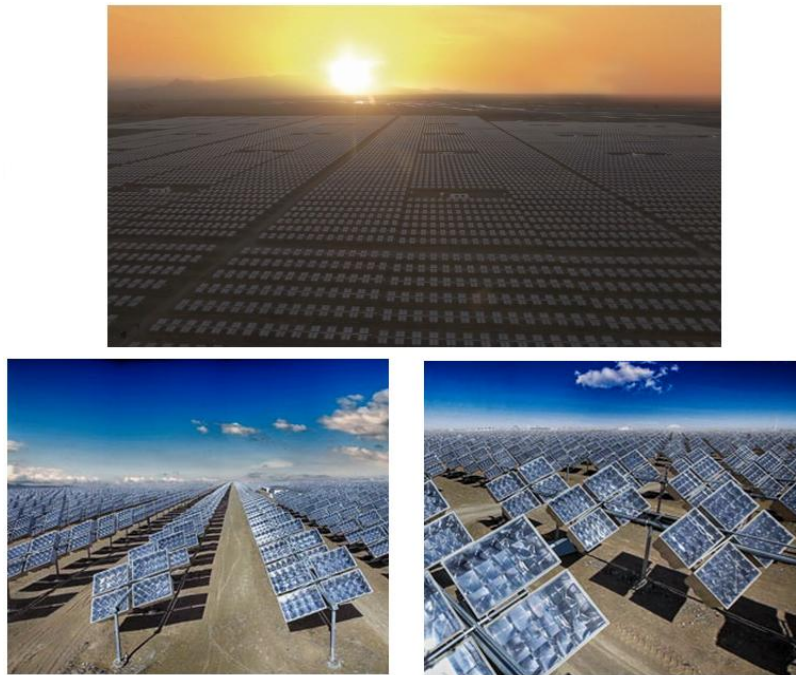
Figura 3.15 –Usina HCPV de 60 MWp em Golmud , na China.
