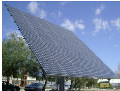
Figura 2.9 - Protótipo de seguidor azimutal/elevação com módulos planos localizada na Universidade de Jaén, Espanha.
