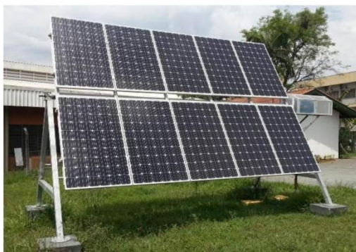
Figura 1. Protótipo de Seguidor Solar de Eixo Horizontal.
