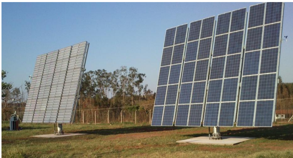
Figura 4.3 - Seguidores instalados no campus III da UNESP com módulos de concentração à esquerda e com módulos planos à direita.
