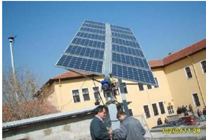
Figura 2.4 - Sistema fotovoltaico com seguidor solar de eixo polar. Fonte: (SEFA, DEMIRTAS e ÇOLAK, 2009)
