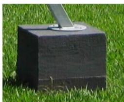
Figura 3. Base de concreto para fixação.
