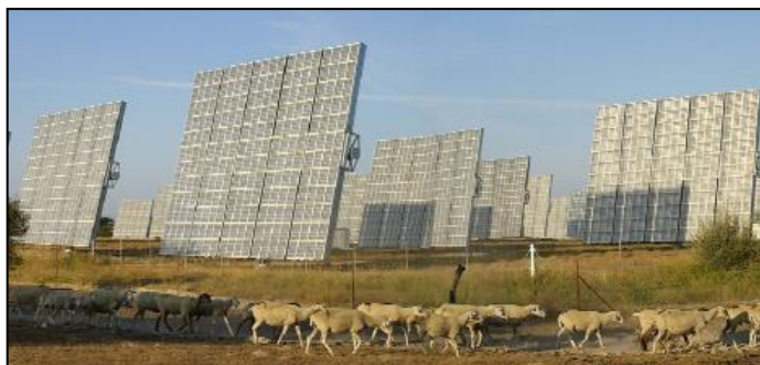
Figura 3.17 – Parte da planta de 12 MWp, com CPV de óptica refrativa, em Villafranca , Espanha.
