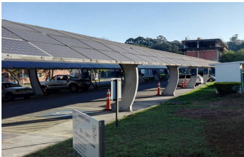
Figura 5.4 - Sistema BIPV, estacionamento solar do IEE-USP.
