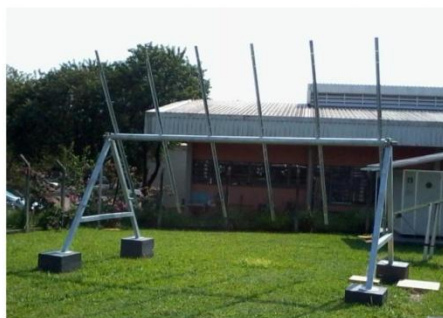
Figura 4. Estrutura metálica do PSSEH.
