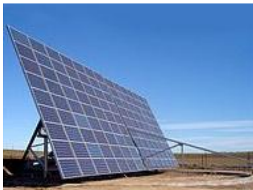
Figura 2.10 - Seguidor de dois eixos do tipo azimutal/elevação.
