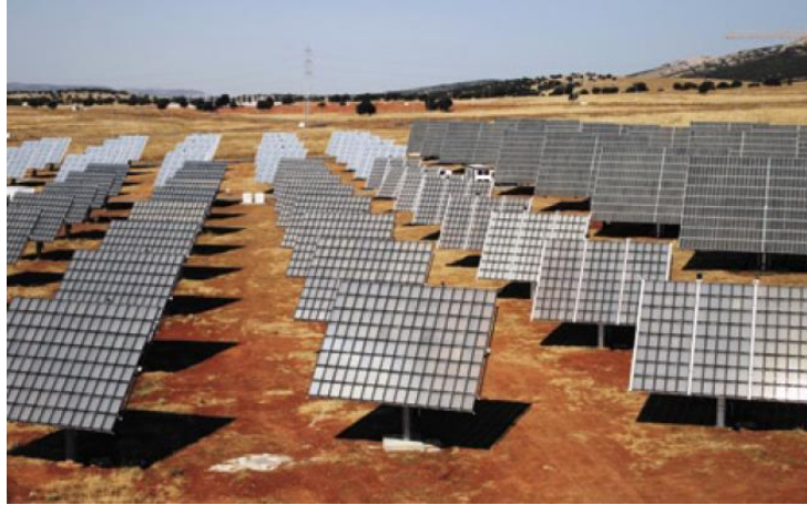
Figura 3.20 - Campo de testes do ISFOC em Puertollano , Espanha, com sistemas CPV instalados, sendo: 200 kW N da Concentrix , frente, 200 kWp da SolFocus , atrás à esquerda, e 400 kWp da Isofotón , atrás à direita.
