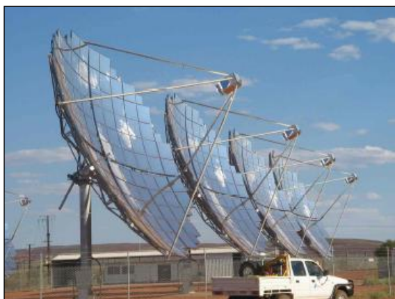
Figura 3.19 - Planta fotovoltaica de 220 kW, com CPV de óptica reflexiva, em Hermannsburg , Austrália.
