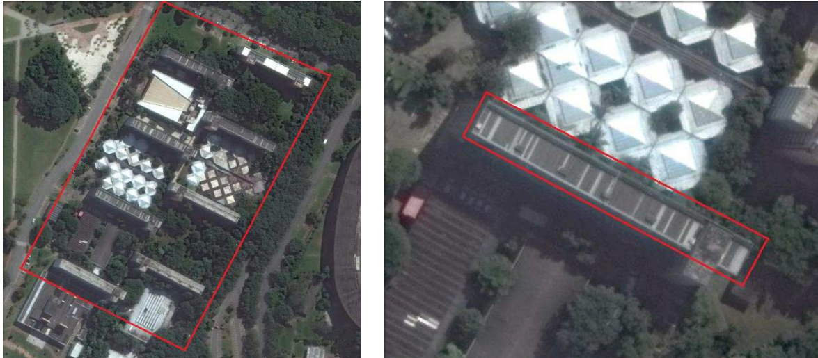
Figura 5.1 - (a) Conjunto Residencial da USP (CRUSP); (b) Detalhe de um dos sete edifícios do CRUSP.
