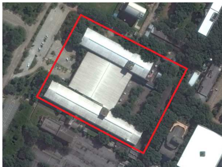
Figura 5.14 - Departamento de Engenharia Elétrica da Escola Politécnica
