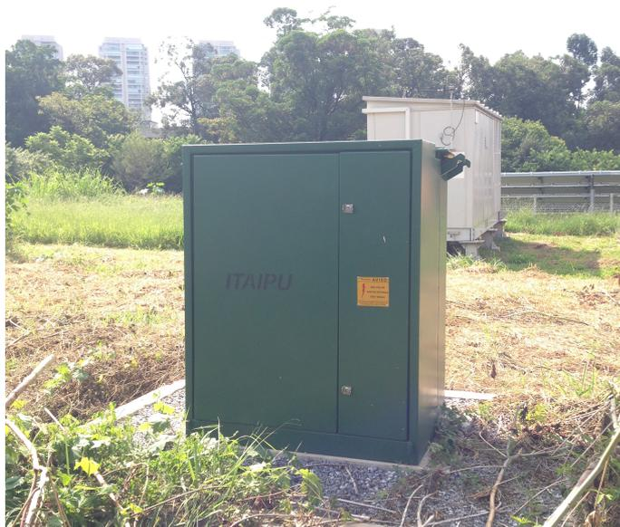
Figura 5.2 - Ponto de conexão à rede e transformador elevador 220/13.800 V.
